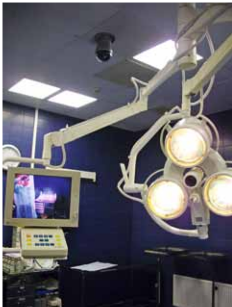
Рис. 3. Типовое оснащение операционной (купольная видеокамера и видеокамера, встроенная в лампу операционной стойки)
