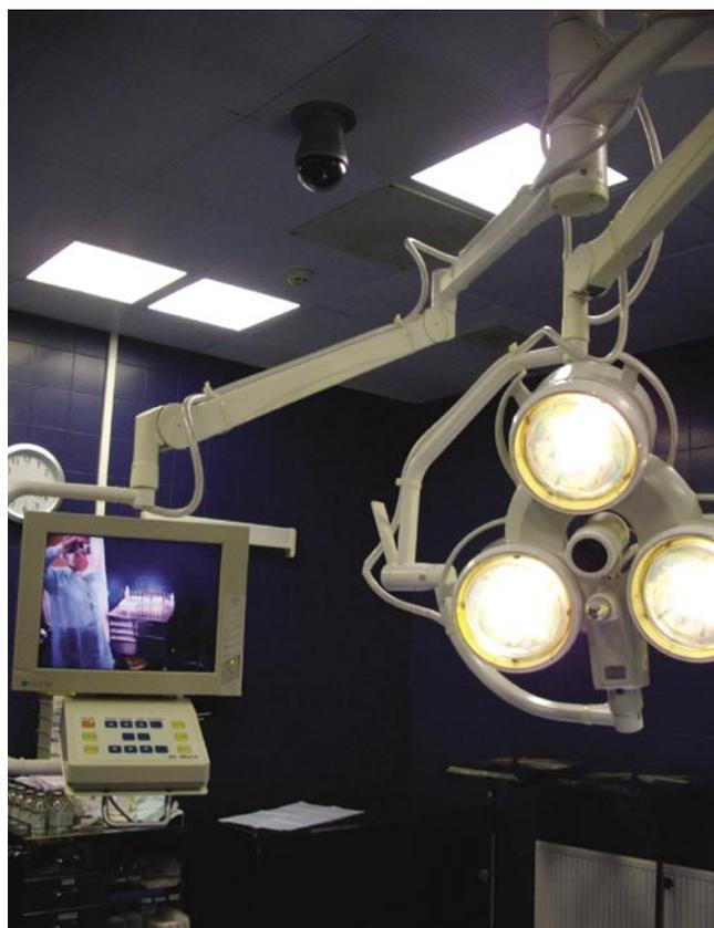
Рис. 3. Типовое оснащение операционной (купольная видеокамера и видеокамера, встроенная в лампу операционной стойки)
